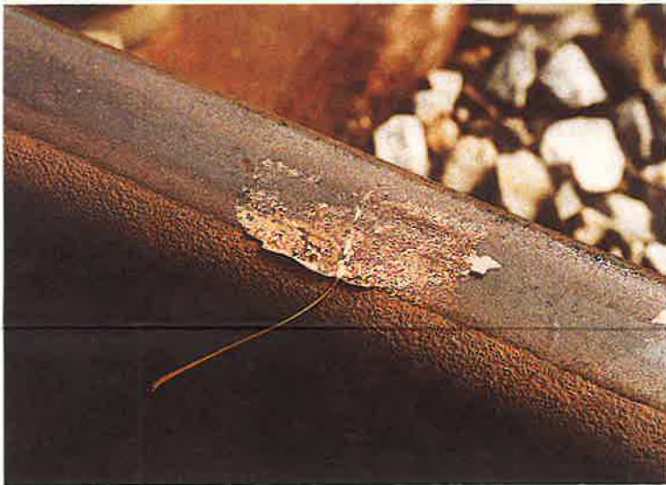
Aux feuilles mortes se fixent des particules et des poussières grasses dues à la pollution. Pour en venir à bout, l'engin projette de l'eau à très grande pression grâce à la pompe et au moteur dont il est équipé.
