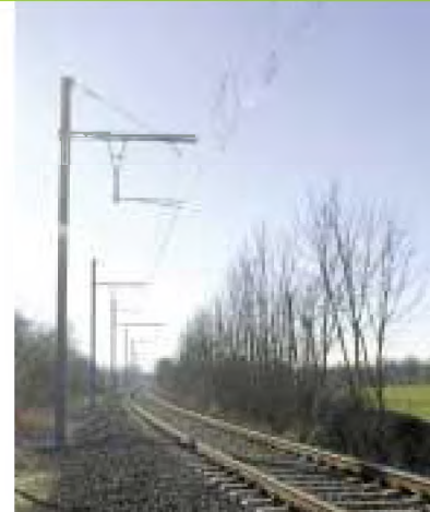
| Elektrificatie tussen Montzen en Welkenraedt
