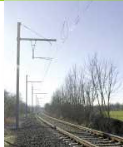
I Electrification entre Montzen et Welkenraedt
