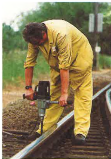
Langgelaste spoorstaven en betonnen dwarsliggers met Pandrol-klassen vergen aanzienlijk minder onderhoud.
