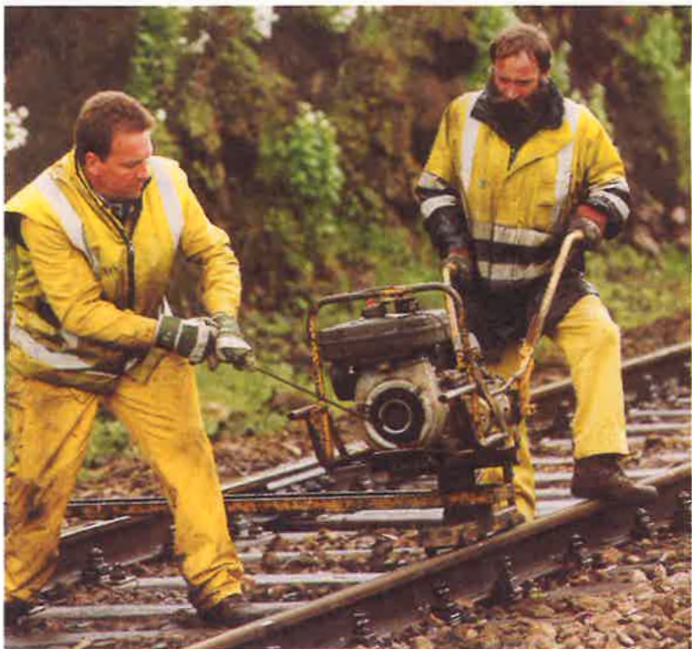
Onder het waakzaam oog van de schildwacht gaan de vakbedienden sporen door met hun werk: met de kraagschroefmachine controleren ze de bevestigingen en vervangen de kraagschroeven, indien nodig.
