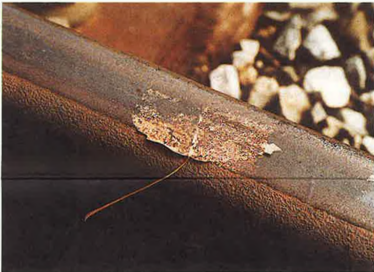
Op de bladeren zetten zich harde deeltjes vast en vette stoffen die hun oorsprong vinden in de vervuiling. De spoorreiniger is uitgerust met een krachtige motor en pomp en spuit met hoge druk de rails schoon.
