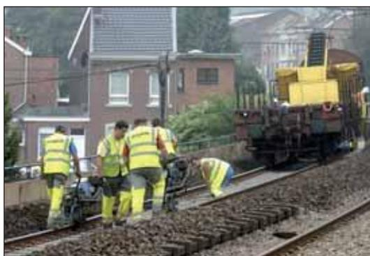
Après 15 à 20 ans de présence dans les voies, le ballast doit être renouvelé. En effet, les pierres finissent par se briser en plus petits morceaux à cause du trafic intense et des conditions climatiques. La cribreuse ramasse alors l'ancien ballast et trie les pierres selon leur taille : les plus grosses sont réutilisées dans les voies où elles rejoignent de nouvelles pierres déversées par la machine et les plus petites sont évacuées comme déchets.
