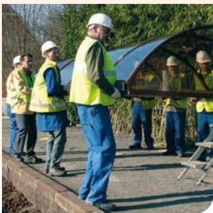
Het dak wordt op het schuilhuisje geplaatst
