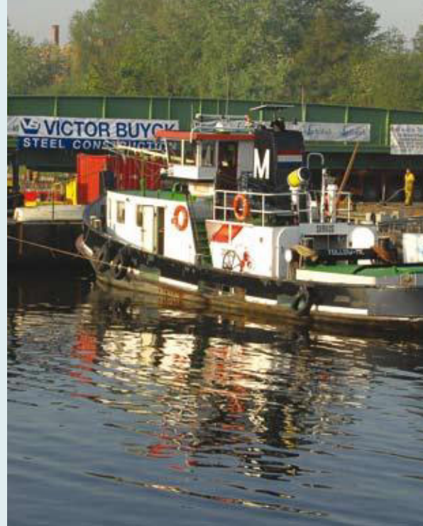
Met behulp van vaartuigen met platte bodems werd de brug op haar plaats geduwd.
