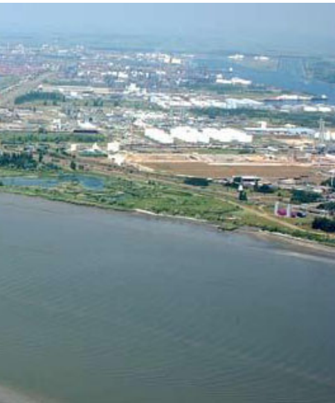
Vue de l'Escaut à l'endroit où le tunnel ferroviaire sera creusé
