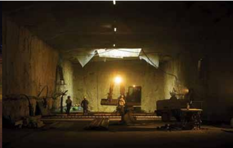
Vanuit deze schacht zal de TBM beginnen boren.
