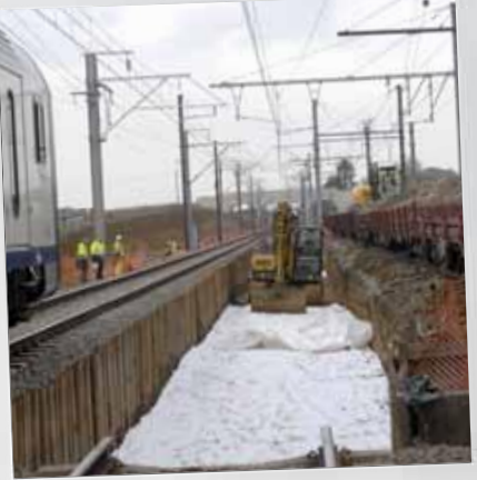
Nadien wordt er een geotextiel geplaatst (om te voorkomen dat de klei naar boven komt in de ballast) dat nadien bedekt wordt met meerdere lagen stenen
