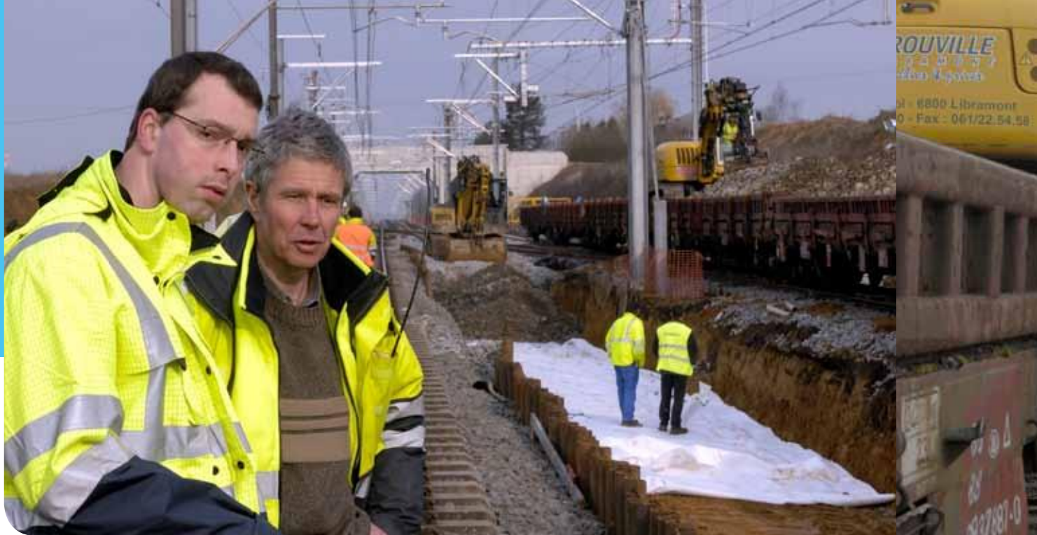
Emmanuel Köhler et Jean Detry supervisent les travaux.
