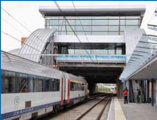
Le point d'arrêt Bruxelles-Ouest a été entièrement déplacé et réaménagé
