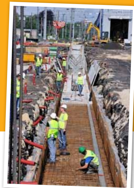
Le timing des travaux est serré mais l'atelier devrait être prêt dans les délais.
