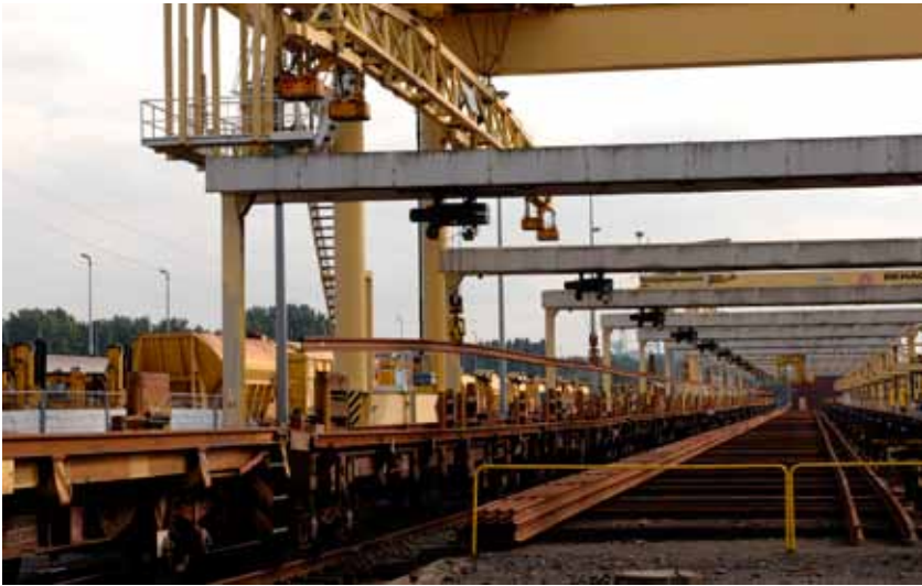
Eenmaal de rails aan elkaar gelast zijn, worden ze met speciale kranen op de trein geplaatst
