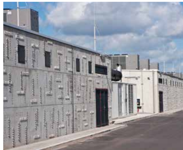
Le data center de Muizen est extrêmement sécurisé.
