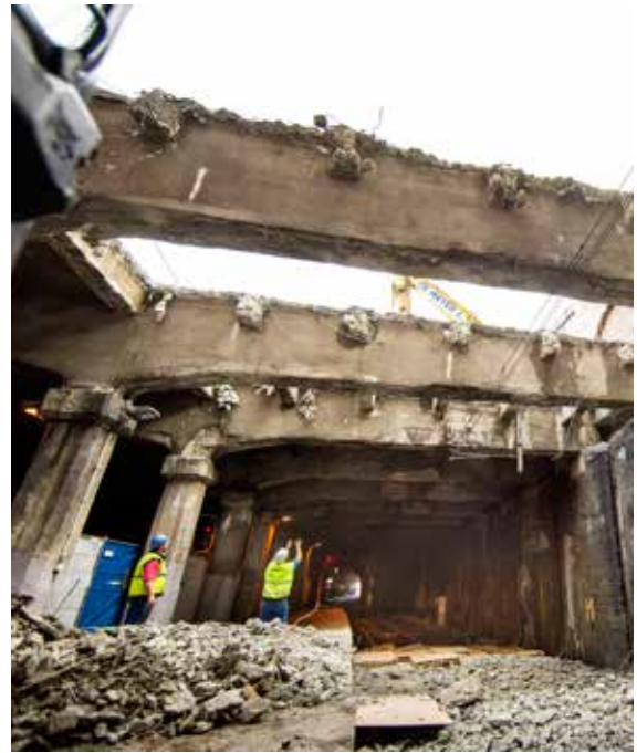
Een tunnelgewelf van bijna 2000 m 2 , of niet minder dan 2000 ton gewapend beton
