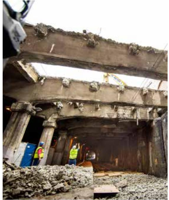
2.000 m<sup>3</sup> de voûte à démonter, soit pas moins de 2.000 tonnes de béton armé.
