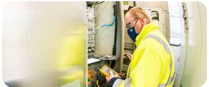
Subvention européenne pour l'installation de systèmes de sécurité ETCS
