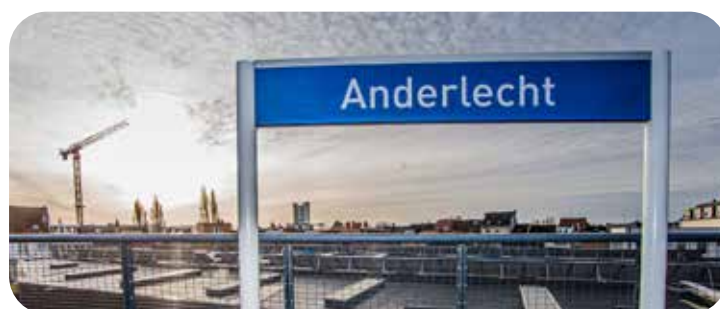
Nouvelle gare à Anderlecht
