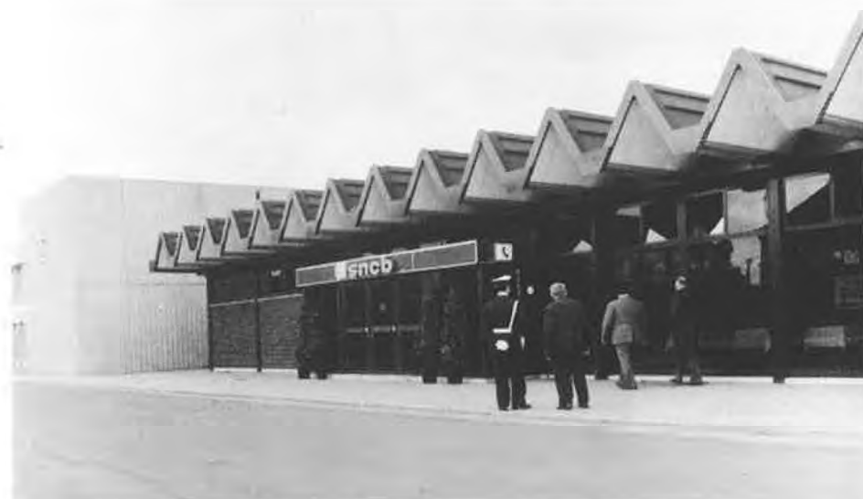
Manage : électrification nouvelle, gare aux lignes modernes
