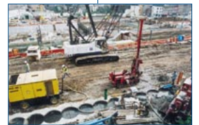
CÔTÉ COLLINE: EMPLACEMENT DES PIEUX QUI FORMERONT L'ENCEINTE DU PARKING.
