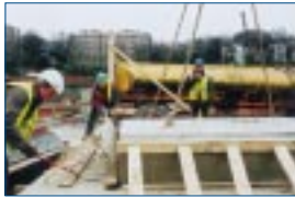
OPÉRATION DE DÉCOFFRAGE.
