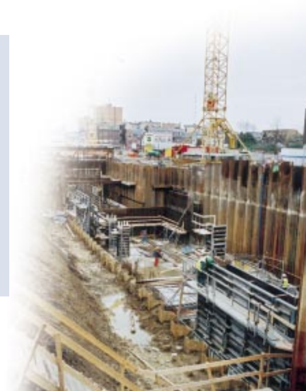
BASSIN D'ORAGE, CÔTÉ MEUSE.
