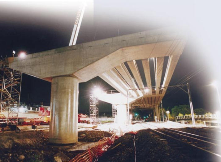
TRAVAUX DE NUIT AU-DESSUS DE LA LIGNE BRUXELLES - LIÈGE (HEMERICOURT).
