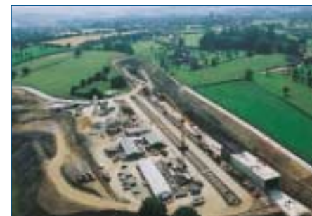
AYENEUX: SORTIE DU TUNNEL DE SOUMAGNE.
