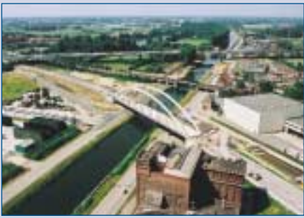
PONT SUR LE CANAL DE LOUVAIN.
