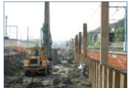
PALPLANCHES ET PIEUX POUR PRÉPARER LA CONSTRUCTION DU QUAI IV.
