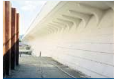
LE MUR DE SOUTÈNEMENT DU QUAÏ 1.
