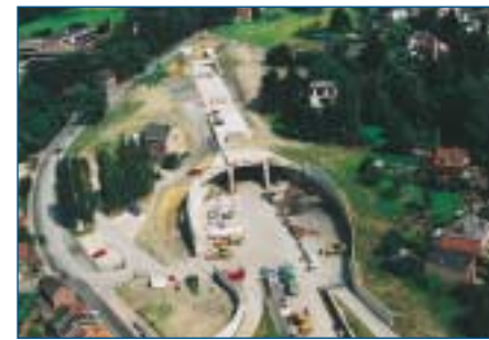
VAUX-SOUS-CHÈVREMONT: ENTRÉE DU TUNNEL DE SOUMAGNE.
