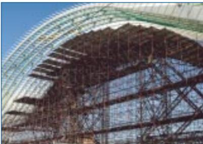
Au fur et à mesure que les abris de quai étaient construits, l'entreprise chargée de la couverture vitrée prenait le relais pour les équiper simultanément de châssis et de vitrage. Pour la voûte, par contre, la pose des châssis et du vitrage s'est effectuée en deux temps. Pas question en effet de placer le vitrage avant que la voûte soit poussée, les auvents montés et l'ensemble stabilisé sur les appuis définitifs.
