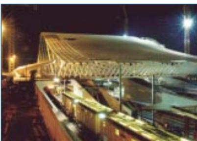
Initialement, la voûte devait être mise en place selon une technique classique mais très contraignante tant pour le fonctionnement de la gare que pour les entreprises. La technique du poussage finalement adoptée a permis d'assembler progressivement la structure hors du domaine ferroviaire avec, à la clé, moins de contraintes pour l'exploitation du site.
