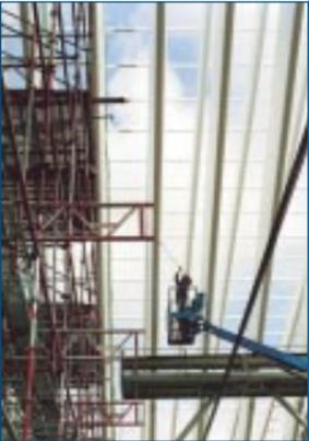
LORSQU'ELLES SONT ARRIVÉES SUR LE CHANTIER, LES PIÈCES AVAIENT REÇU UNE PREMIÈRE MÉTALLISATION EN ATELIER. DEUX COUCHES DE PEINTURE ÉTAIENT PRÉVUES SUR CHANTIER, L'UNE INTERMÉDIAIRE ET L'AUTRE DE FINITION.
