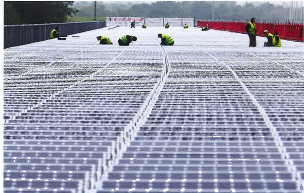
Installatie van zonnepanelen op het tunneldak van de hogesnelheidslijn ten noorden van Antwerpen.
