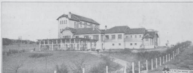
Afb. 10. Gebouw met recreatie- en slaapsalen.
