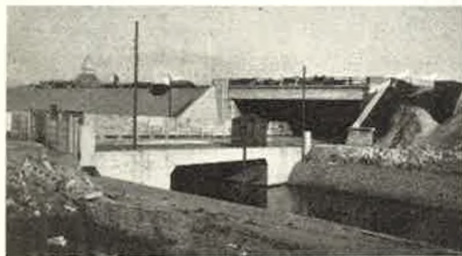
Afb. 3. Viaduct van de Th. Verhaegenstraat. Op den voorgrond de Zenne na omlegging. Op den bovenrand van het zandtalud de zwarte betonmassieven, die de steunpalen der elektrische luchtgeleiding zullen dragen.
