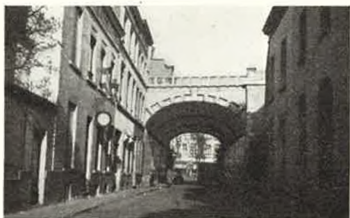
Afb. 6. Viaduct over de Sallaertstraat. De landhoofden waren vóór den oorlog voltooid; het gewelf werd in 1937 gemaakt.
