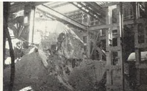
Afb. 17. Een motorschop aan het werk binnen den tunnel.
