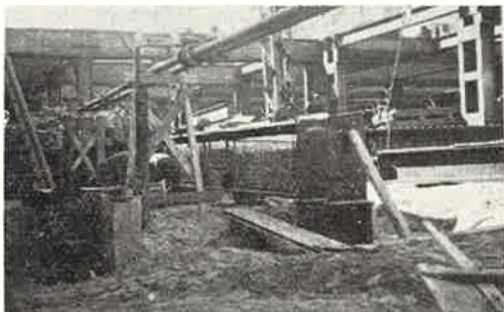
Afb. 15. Koppen van twee stijlen, die in 8 m diepe putten staan; de begane grond is hier nog op het niveau van het tunneldak.
