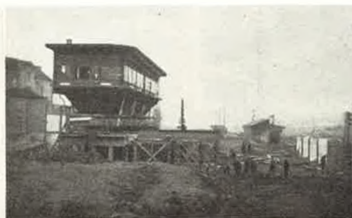
Afb. 10. Verplaatst seinhuis te Brussel-Noord; de witte pijlers rechts zijn de vroegere steunpunten van het seinhuis.
