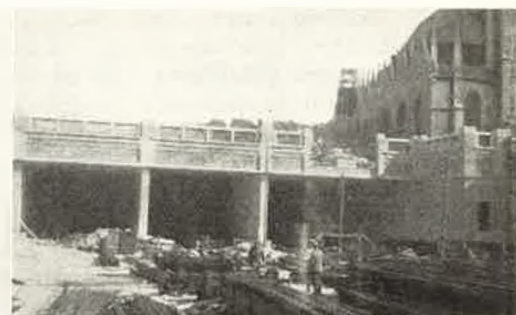
Afb. 8. Zuidelijk tunnelhoofd voltooid. In den rechter koker de trap naar het perron der stopplaats. Rechts boven de Kapellekerk.
