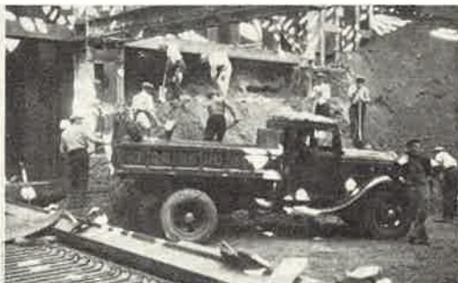
Afb. 16. Vrachtauto's voeren het afgegraven zand weg om dit op het werk te Brussel-Zuid te gaan storten.
