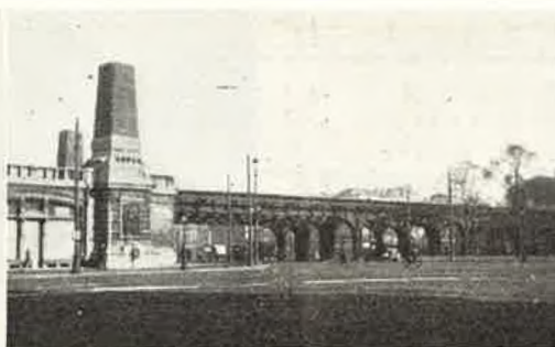
Afb. 7. Viaduct over het Zuidbolwerk. De muur links dekt een reeks kleine viaducten, waaronder winkels ontworpen zijn.
