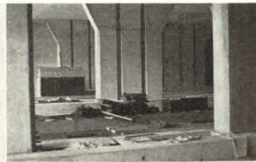
Afb. 13. Doorzicht door de 3 tunnelkokers; de nissen op den achtergrond dienen voor opstelling seintoestellen en als schuilplaats.
