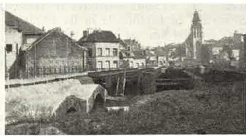
Afb. 5. De verhoogde baan met de reeks ijzeren viaducten, die naar den tunnel leiden. Links op den voorgrond twee gewelven, die deel uitmaken van den steunmuur. Rechts op den achtergrond de Kapellekerk.
