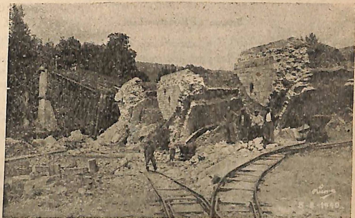
Destruction de voûtes. Pont sur l'Amblève à Remouchamps.
