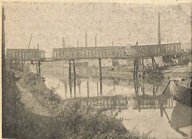
Pont de Châtelet (tablier métallique). Reconstruction.
