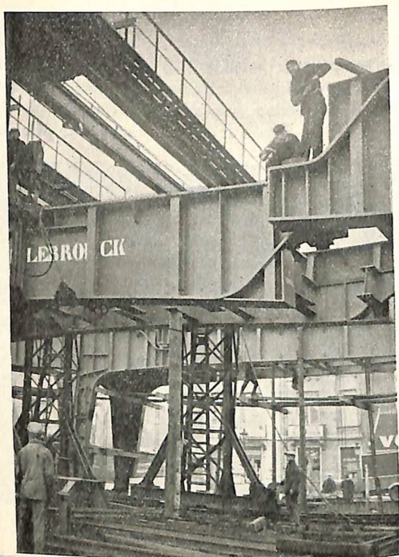
Montage d'une travée intermédiaire.
