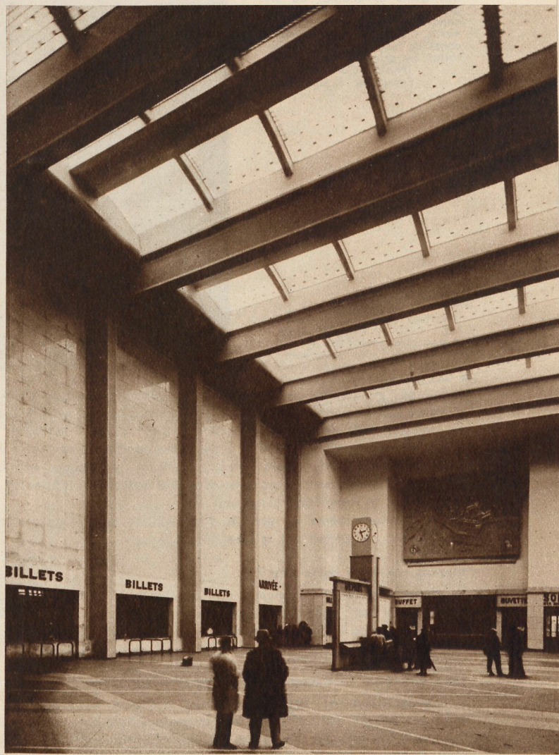
GARE DU HAVRE. HALL DES VOYAGEURS, DONT L'OSSATURE EST EN BETON, COTE DES GUICHETS. ARCHITECTE H. FAÇON. (PHOTO SCHALL, PARIS.)
