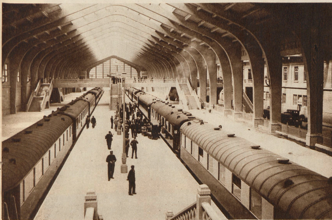
La Gare Maritime de Cherbourg est un type caractéristique de gare en béton. Voici le hall des trains, montrant les passerelles qui mènent aux quais les voyageurs venant des diverses salles des services. A droite, en contrebas, la route de Paris, qui entre dans cette gare « Terminus ».
