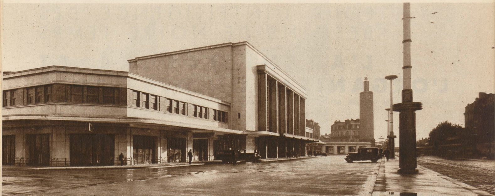
LA NOUVELLE GARE DU HAVRE (ARCH. H. PAÇON) FAIT PARTIE (AVEC VERSAILLES-CHANTIERS ET PARIS-MONTPARNASSE) DES GARES RECENTES DONT LA CONSTRUCTION DÉFEND UN PLAN DE MODERNISATION DES BATIMENTS DU RESEAU DE LA COMPAGNIE DES CHEMINS DE FER DE L'ETAT. (PHOTO SCHALL, PARIS.)
