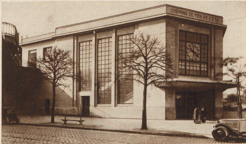
Gare de Paris-Montparnasse (annexe du Maine) : sortie des voyageurs sur l'avenue du Maine. Architecte Ventre.
