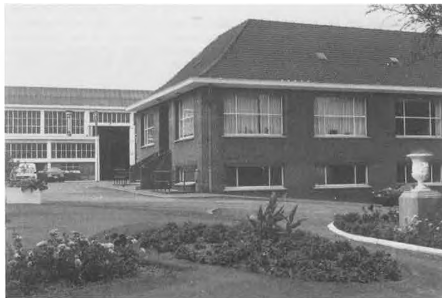
2. Administratief gebouw met links de inrijpoort van de werkplaats.
