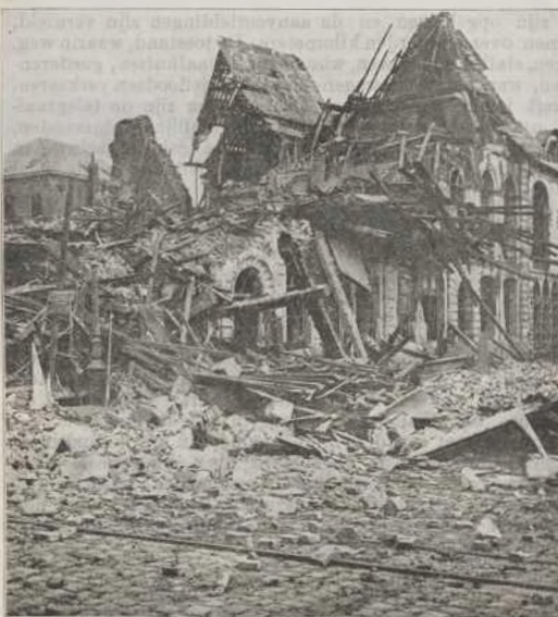
Opgeblazen met dynamiet.
