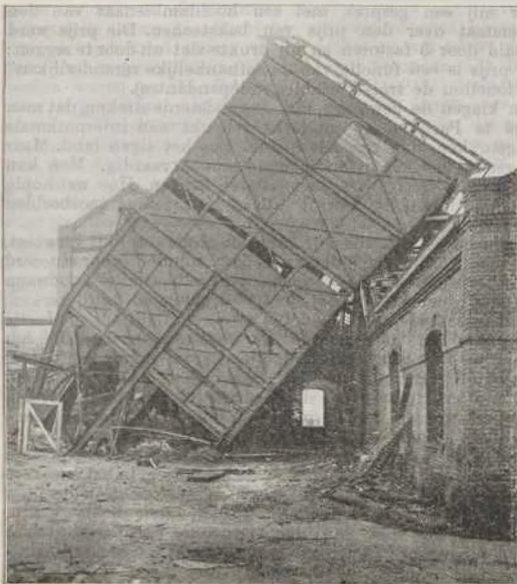
Gebouw omgekegeld bij de ontploffing.
