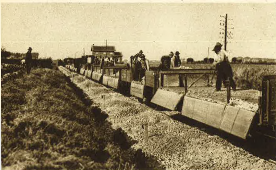
Déchargement de ballast. Ontlading van ballast.
