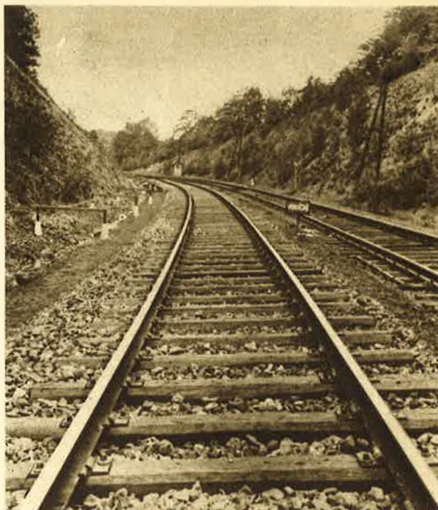
Voie en rails, 50 kgr., avec plaques à crochets et cales sur traverses en bois.
