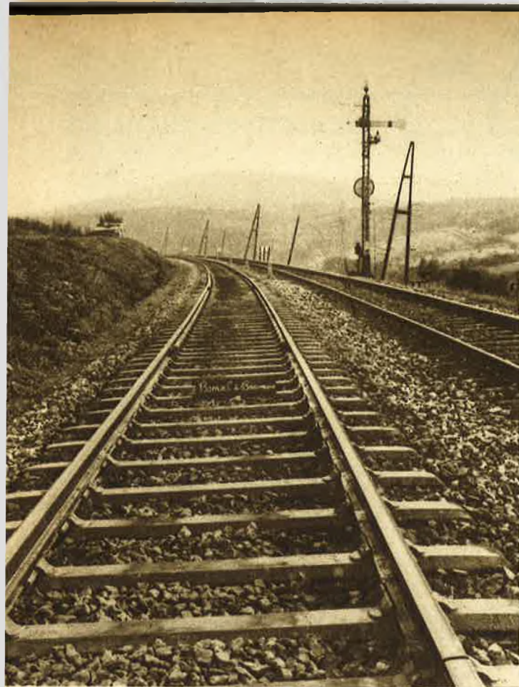
Voie en rails, 50 kgr., avec selles à crochets soudées et cales.
