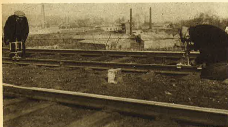
Nivellement de la voie. Gelijkglegging der baan.
