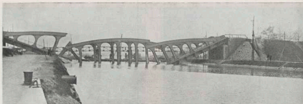
Fig. 7. Ingestorte brug.
