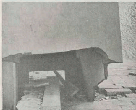
Fig. 12. Neergevallen gedeelte bovenrand; men lette op de schiffelige breuk rechts.
