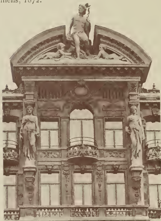
Entrée du Passage des Postes.
