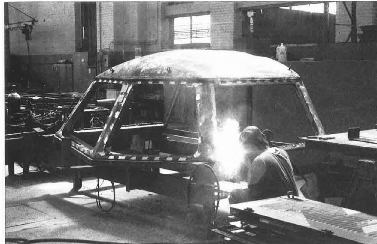
Travaux de soudure sur l'ossature d'un poste de conduite de locomotive diesel (visite, n° 13).
