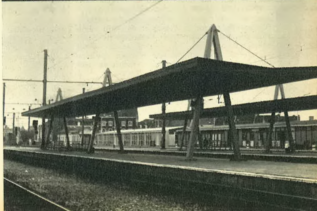
Foto 12 : Paraplu-schildak met omgekeerde V-portieken uit dik plaatstaal dat een bekisting vormt. De trekkers vervullen hier dezelfde rol als in het schildak van foto 11.
