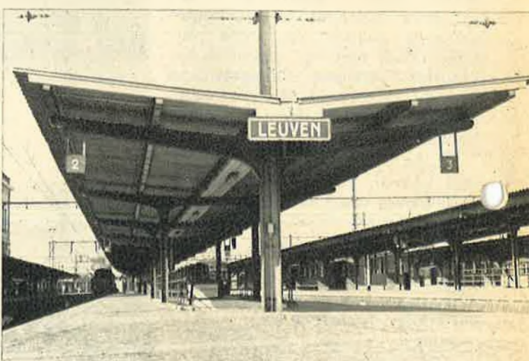
Foto 9 : Verbeterd type van paraplu-schuldak met portieken in T-vorm. Combinatie van gelaste en met bouten bevestigde delen. Lichte langsliggers. Zichtbaar dak van gegolfde asbestcementplaten.
