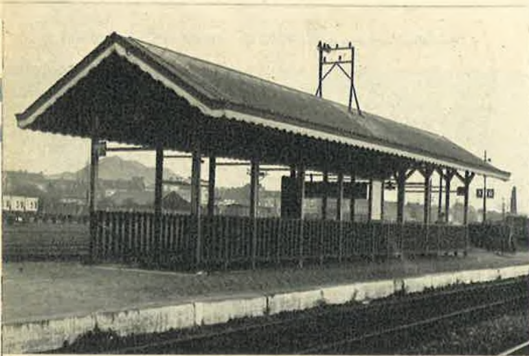
Foto 6 : Trapoverkapping met houten timmerwerk en hellend dak bedekt met leien.
