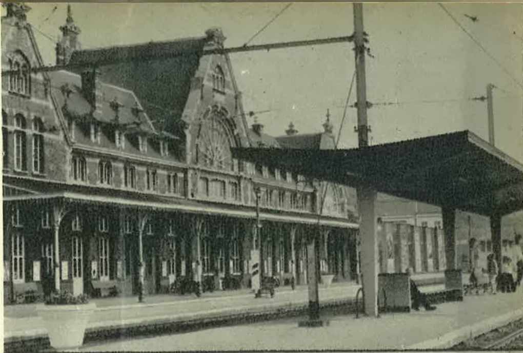
Foto 10 : Paraplu-schildak met nieuwe vorm. Portieken van dik plaatstaal, geplooid in de vorm van een bekisting waarin de paal van de bovenleiding opgenomen is. Plafond met geverniste houten latten. Beglaasde windschermen met vaste zitbanken en reclameborden. De waterafvoerbuizen en de elektrische leidingen zijn onzichtbaar.
