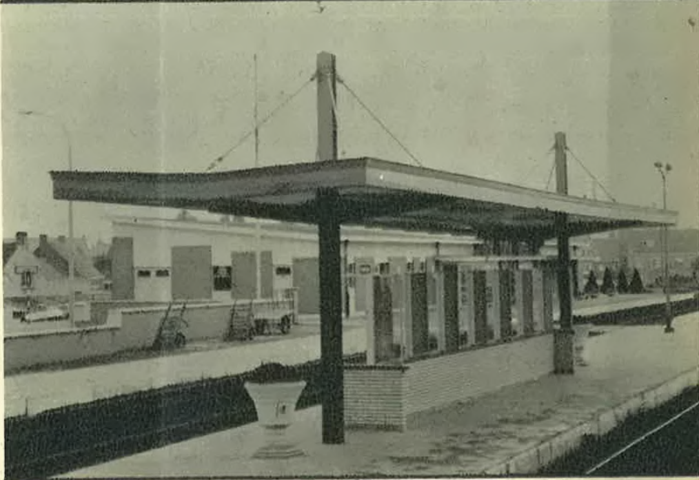
Foto 11 : Zeer elegant paraplu-schildak. De trekkers rondom de paalkop dienen om de afstand tussen de portieken te verhogen en de draagwijdte van de overkraging te vergroten zonder de liggers te verzwaren.
