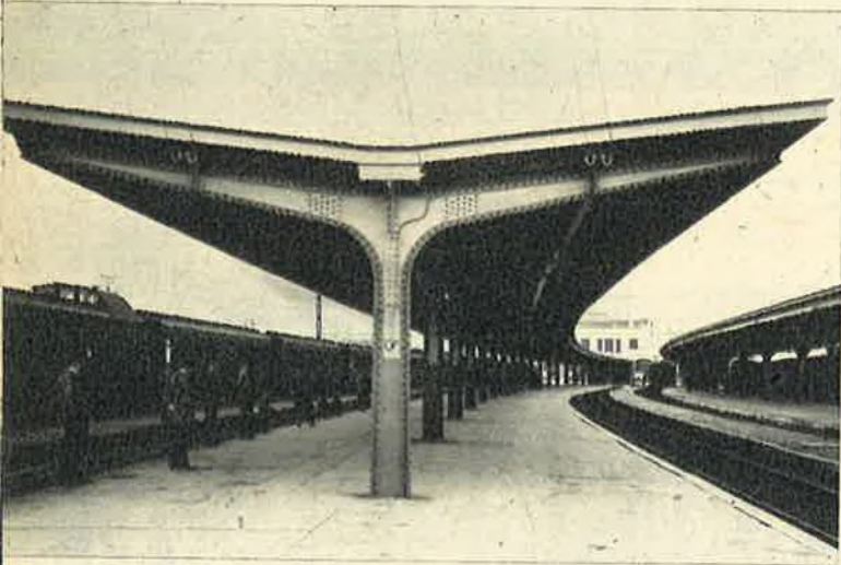
Foto 8 : Oud type van paraplu-schuldak. Portieken in T-vorm met zichtbare klinkbouten, hoge langsliggers in vakwerk. Zichtbare houten kepers en beschiëting met zinkbedekking.
