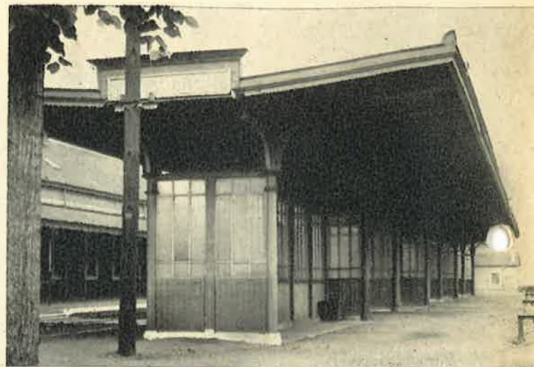
Foto 7 : De eerste voorganger van de paraplu-schuldaken. Paarsgewijze geplaatste gietijzeren kolommen, metalen begloasde windschermen en plat dak.
