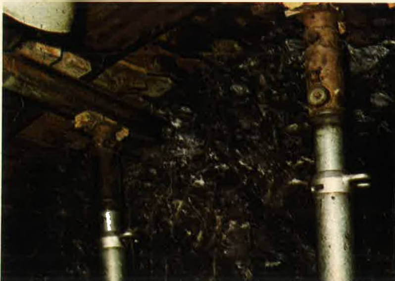
Foto 4 : ingang richting Namen - Buitenaanzicht van de blinderingsplaten (« liner-plates »). De horizontale damplanken zijn geplaatst, hun indringen in het rotsgesteente is begonnen. Bovenaan, in het midden, toestel voor het verplaatsen van de formelen.
