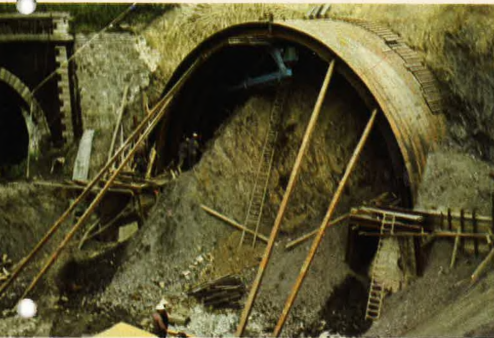
Foto 4 : ingang richting Namen - Buitenaanzicht van de blinderingsplaten (« liner-plates »). De horizontale damplanken zijn geplaatst, hun indringen in het rotsgesteente is begonnen. Bovenaan, in het midden, toestel voor het verplaatsen van de formelen.
