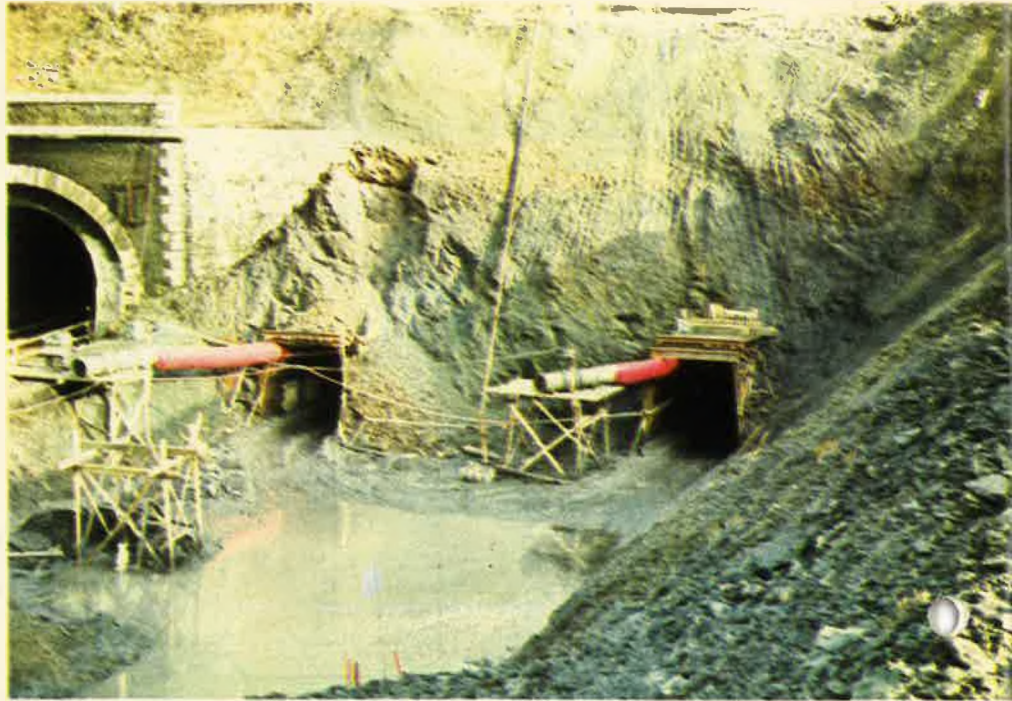
Foto 1 : ingang richting Namen - uitmonding van de galerijen. Let op de verluchtungsbuizen van het werkfront en het slijk dat uit de galerijen vloeit.
