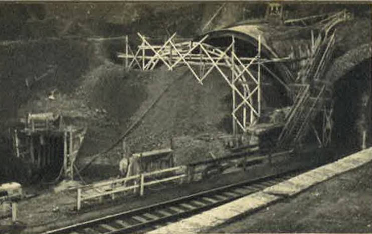
Foto 8 : monding van de uitgraving aan de ingang naar Luik (geboord op 14-12-68).
