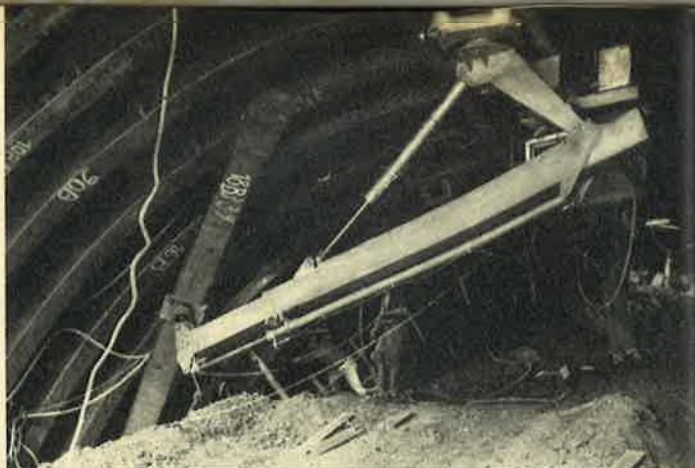
Foto 7 : werkfront. Plaatsen van een formeel.
