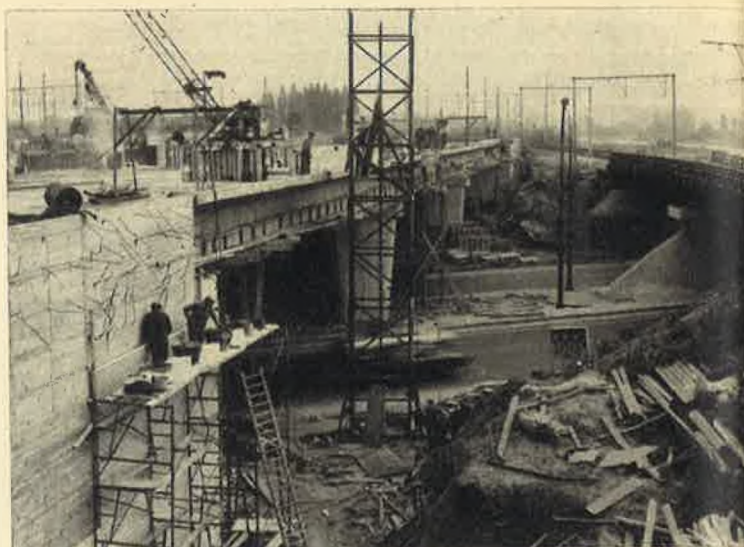
● De in opbouw zijnde brug over de Kleine Ring. Totale overspanning : \pm 100 m ; oppervlakte van het kunstwerk : \pm 1/2 ha.
