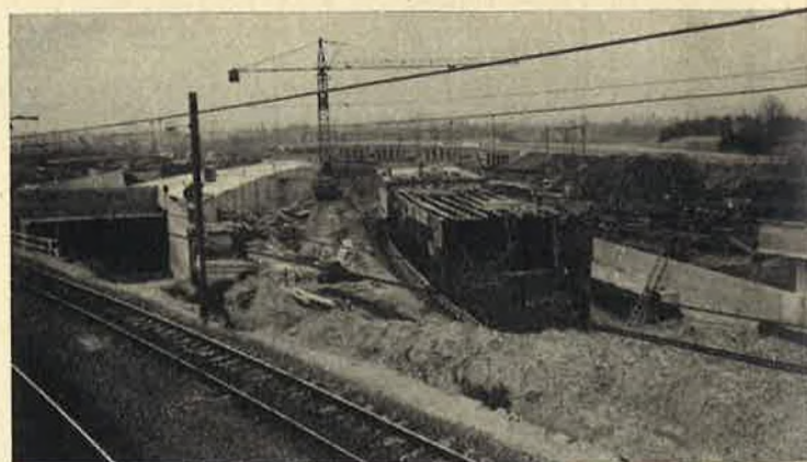
● De constructie van de twee kokerbruggen voor de lijn 59 schiet flink op. Links, de koker voor het goederenvervoer ; rechts die voor het reizigersvervoer.
