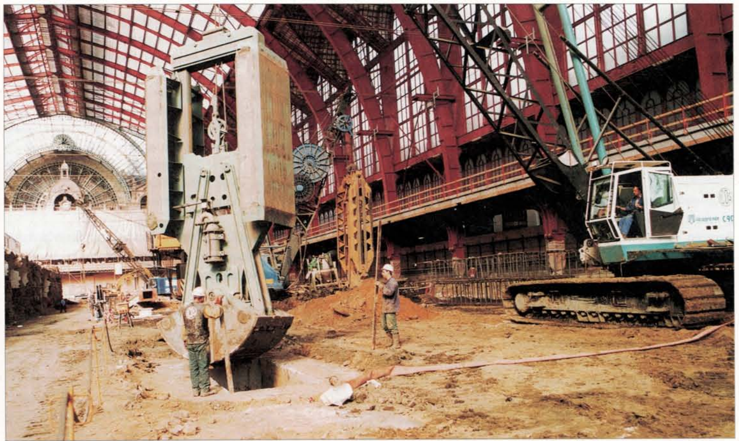
Aanleg van de tunnelwanden onder de overkapping van het station met behulp van bentoniet.
