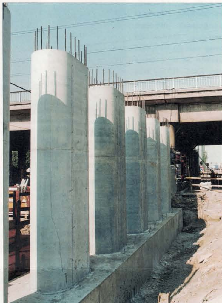
Voor het plaatsen van de funderingspalen van de nieuwe bruggen en het verleggen van de nutsleidingen moest de verkeerssituatie op de Groenendaallaan een aantal maanden gewijzigd worden. De funderingen zijn intussen klaar en de verkeerssituatie verloopt opnieuw normaal.
