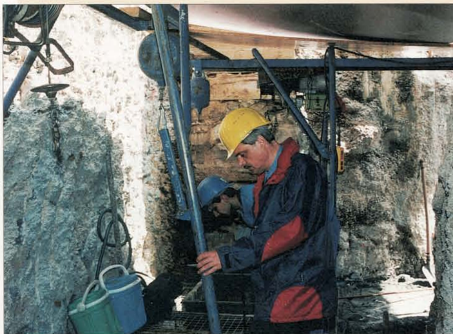
Ook aan de Belgiëlei worden arbeiders ingezet om de wanden uit te graven. Op die manier kunnen onder de brug funderingen worden aangebracht.
