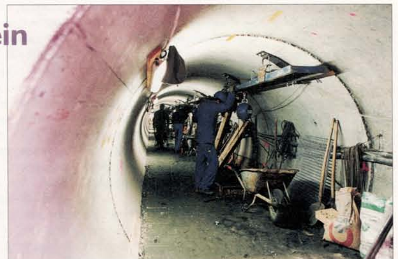
Vanuit de geperste buizen graven werknemers de wanden voor de spoortunnel.
