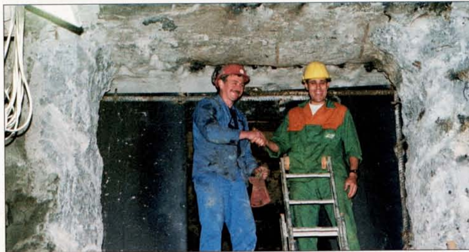
Op 3/10/2001 werd de 1e opening achteraan de tunnel onder Antwerpen-Centraal gemaakt en konden de arbeiders elkaar de hand schudden.
