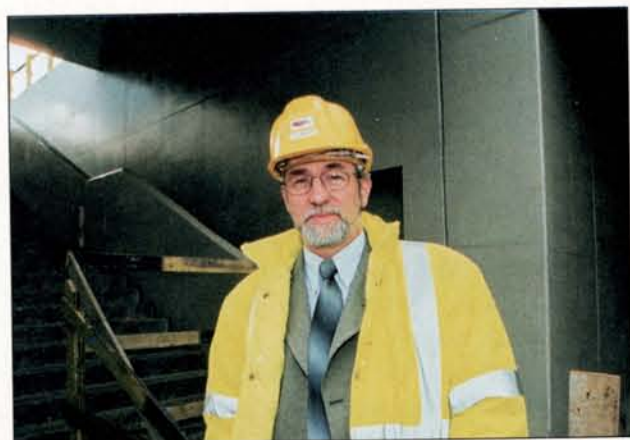
"Tijdens deze fase van de werken worden onder meer de toegangen naar de 350 meter lange perrons van het toekomstige station Antwerpen-Luchtbal aangelegd", vertelt Philippe Gillet van TUC RAIL.
