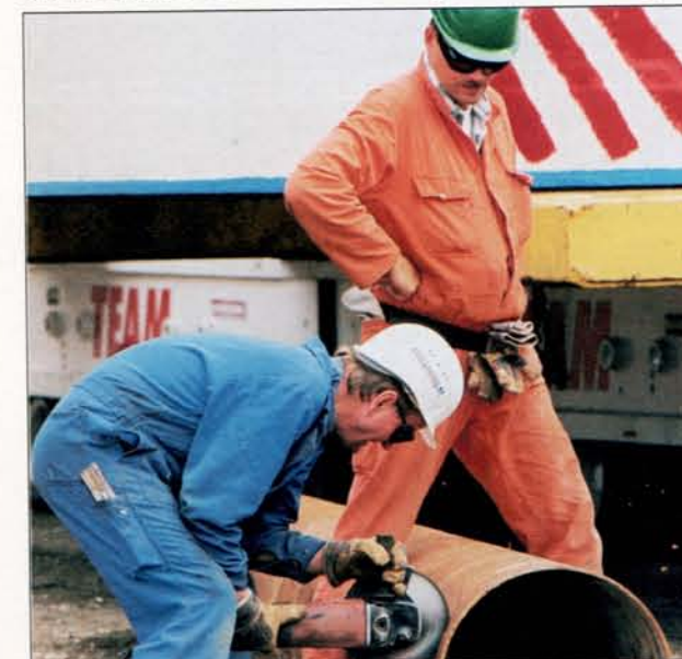
Wanneer alle onderdelen in de bouwput zijn neergelaten, kon de montage beginnen.
