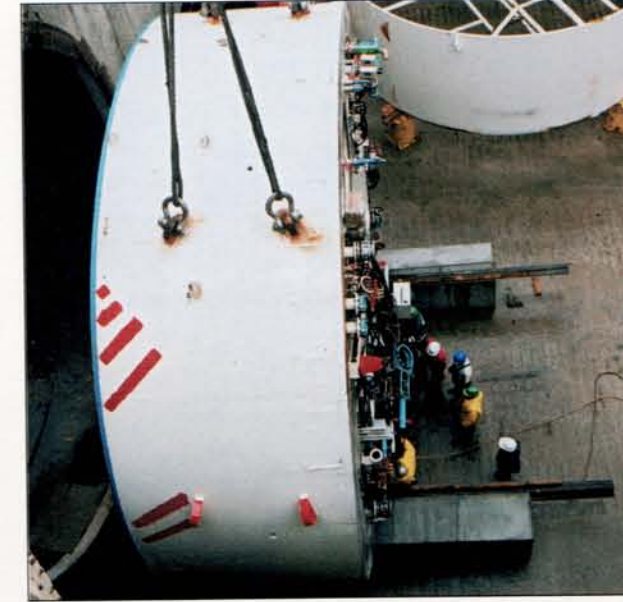
De boorkop werd voor de opening van de eerste tunnelkoker geplaatst.
