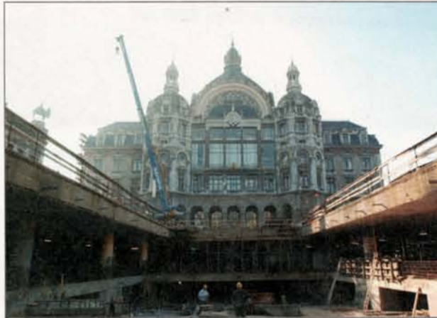
Onder het Astridplein wordt er volop gewerkt aan de parking en de ondergrondse niveaus.
