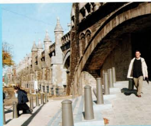
Sinds november kunnen voetgangers door de nieuwe onderdoorgang aan de Arendstraat wandelen. Fietsers kunnen met de fiets aan de hand onder de brug passeren.
