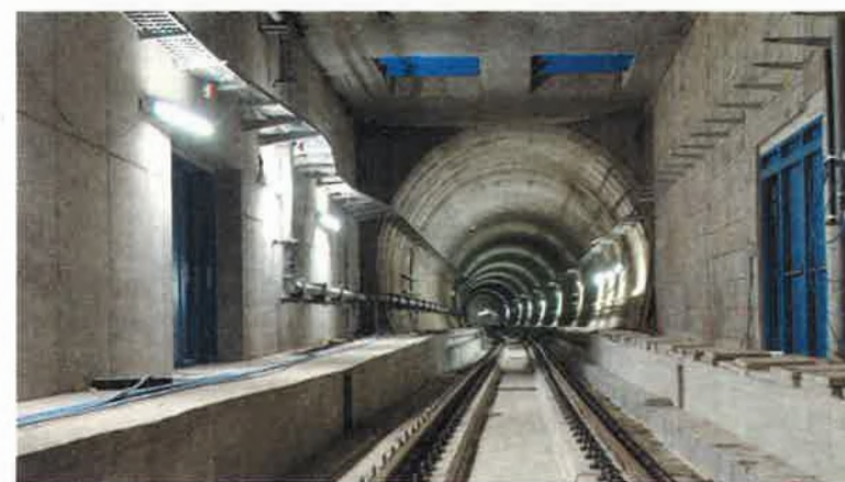
De tunnelkokers tussen het Centraal Station en Antwerpen-Dam zijn zo goed als afgewerkt. Ook de sporen zijn reeds geplaatst.
