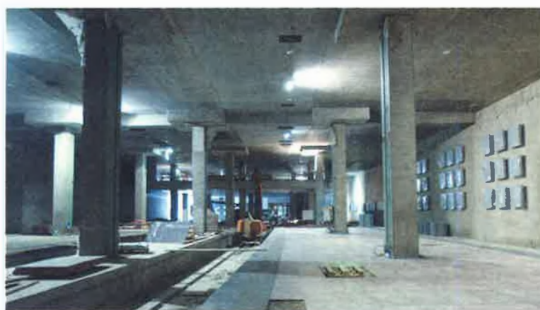
De perrons op het -2 niveau van Antwerpen-Centraal krijgen duidelijk vorm.
