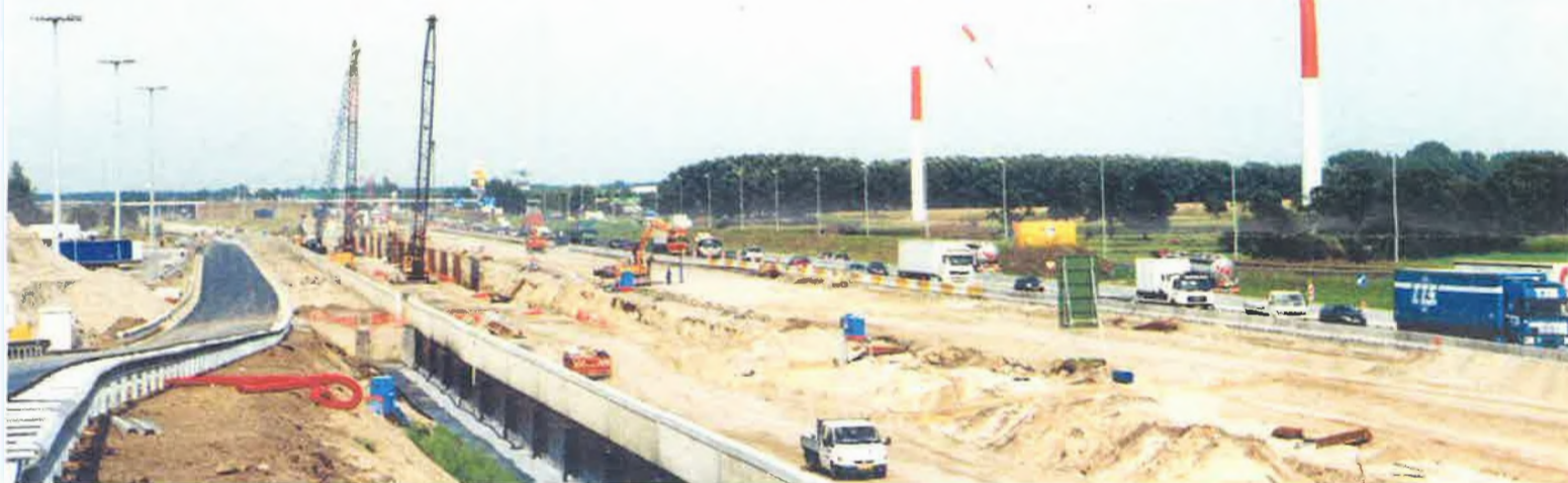
Zicht op de werken voor de verplaatsing van de autosnelweg in Meer.
