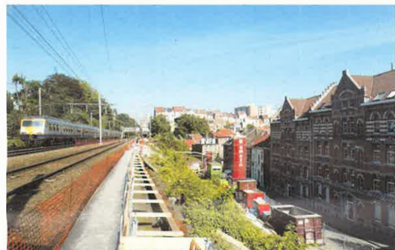
Werken voor de verbreding van de spoorbedding langs de Tweebruggenstraat.
