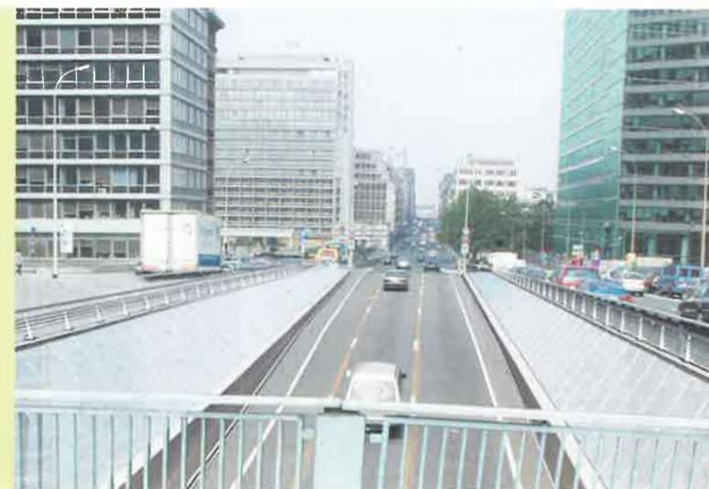
2 Aan beide kanten van de toegangshelling van de tunnel aan de Wetstraat komen glazen panelen zodat het daglicht kan binnenvallen in het nieuwe station.
