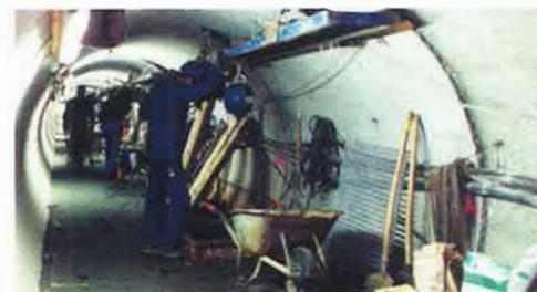
La technique du creusement en galerie a été utilisée avec succès lors des travaux de la jonction souterraine passant sous la gare d'Anvers-Central.
