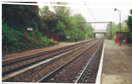
In Nossegem zijn sinds juni 2000 moderniseringswerken aan de gang. Aan beide kanten van de lijn komt een extra spoor.
