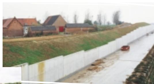
Dankzij een U-vormige constructie blijft de geklasseerde hoeve aan de Katspoelstraat van onteigening gespaard.
