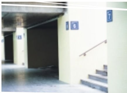
De oude gang ruimt plaats voor een acht meter brede onderdoorgang.
