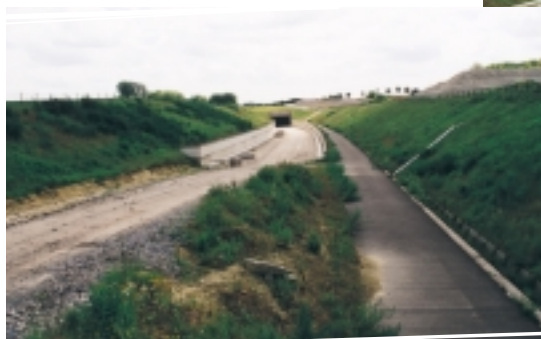
De tunnel onder de E40 in Bierbeek is al enige tijd volledig klaar. Enkel de spooruitrusting moet nog worden aangelegd.
