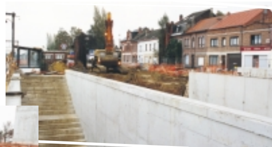
De opgefriste stopplaats Veltem-Beisem krijgt een nieuwe onderdoorgang met goed verlichte toegangshellingen en -trappen.
