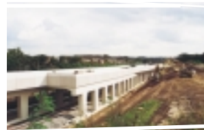
In de omgeving van de Abdij van Park komt een nieuw kruisingscomplex. Hier zullen de bestaande spoorlijn 36 en de nieuwe hsl elkaar kruisen.
