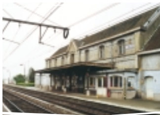
Ook Kortenber krijgt een gloednieuw stationsgebouw. Het oude station wordt afgebroken en vervangen.
