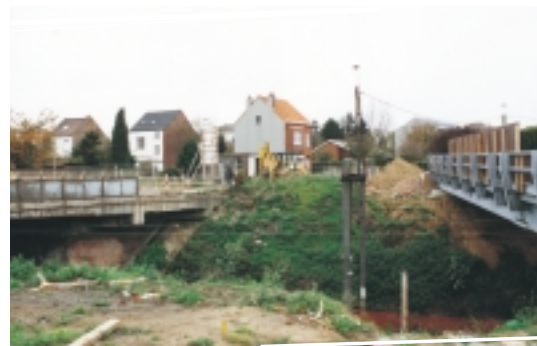
De nieuwe brug aan de Mechelsesteenweg is volgens de huidige planning klaar in november 2001.
