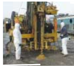
Staalname na een incident met een goederentrein.
