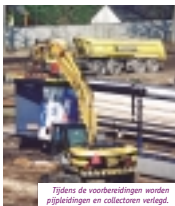
Graafmachines aan het werk vlak naast de E19.
